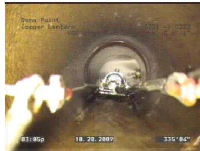
Launcher latéral pour conduite principale 6" avec moteur 0-24 vdc.
