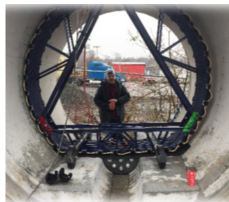
Packer pour conduite 2400mm avec cunette
